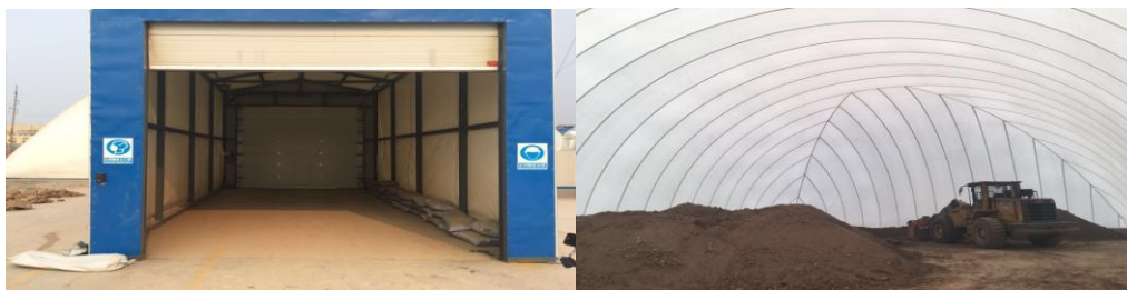
图 3.7-2 现场密闭大棚建设情况
